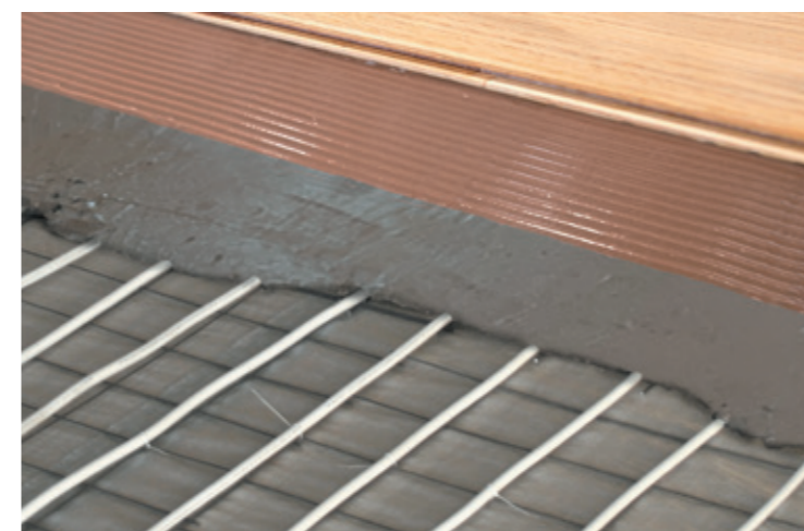
▼ Elektrische vloerverwarming met verwarmingsdraden op net
