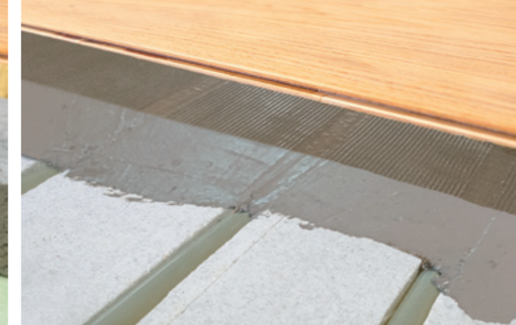
▲ Infrezen van de bestaande dekvloer
