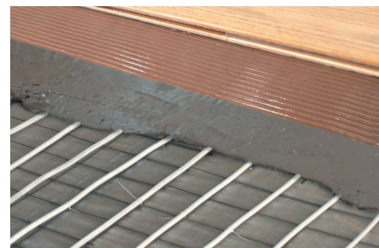
▼ Elektrische vloerverwarming met verwarmingsdraden op net
