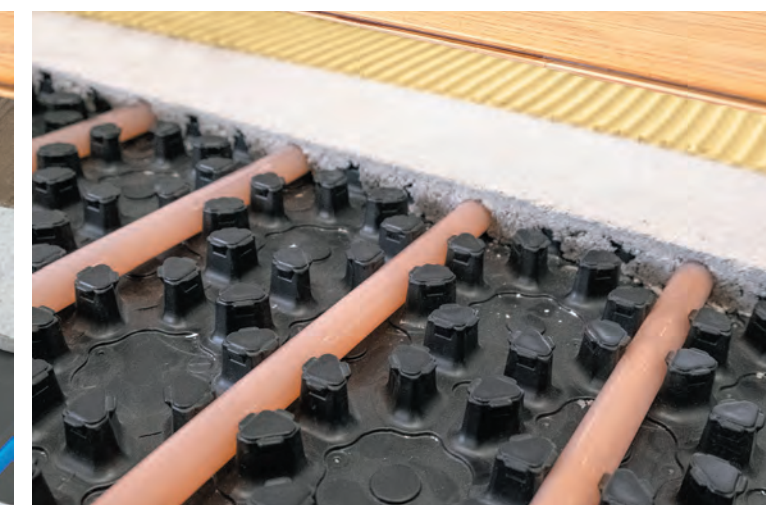
▲ Kunststof platen aan de ondervloer verbonden
