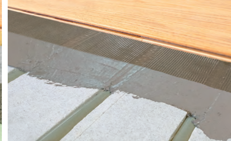
▲ Infrezen van de bestaande dekvloer
