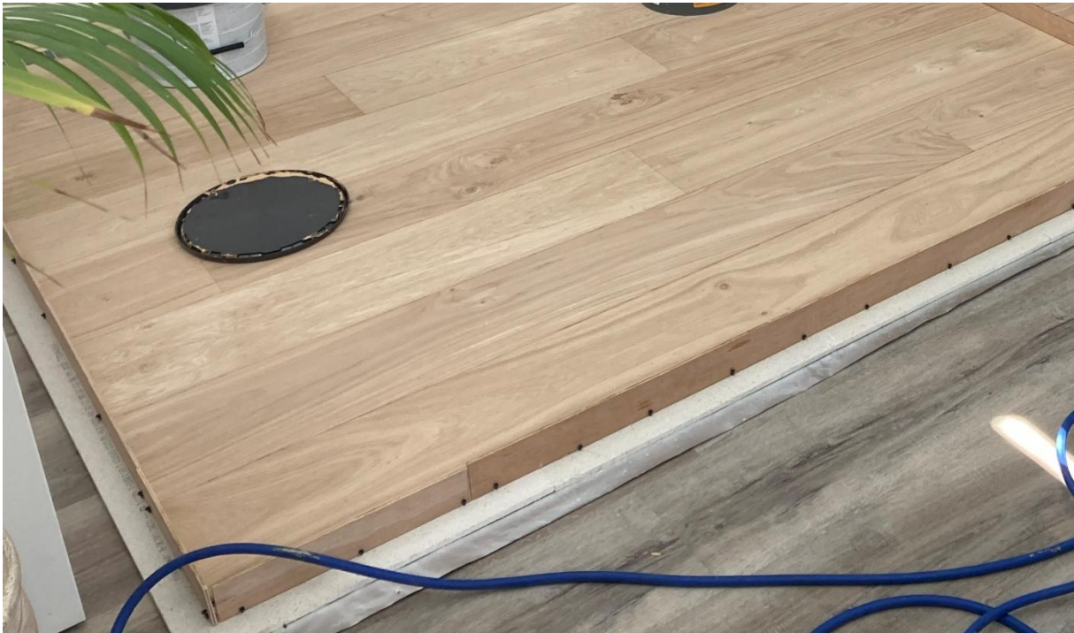
Afbeelding 20: duoplank bij installatie
