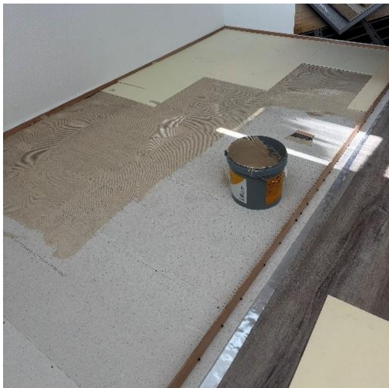
Afbeelding 1: verlijmen XPS
